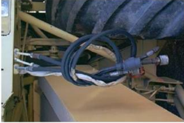
Collegamenti idraulici privi di supporto
