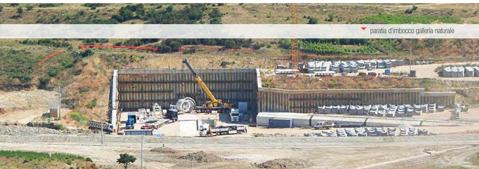
▲ montaggio del sistema meccanizzato TBM-EPB
