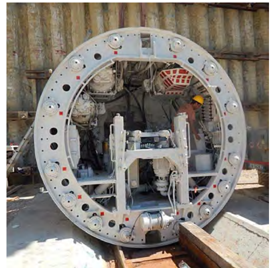
▲ montaggio del sistema meccanizzato TBM-EPB
