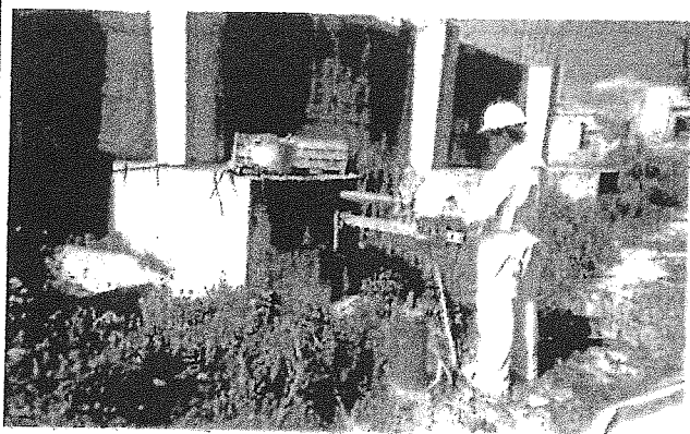
Foto n°1 - Fase di estrazione della carota C4
